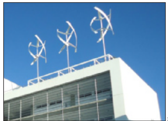
Abb. 29: Beispiele für Kleinwindanlagen in Wohngebieten oder auf Häusern in Pilotprojekten
