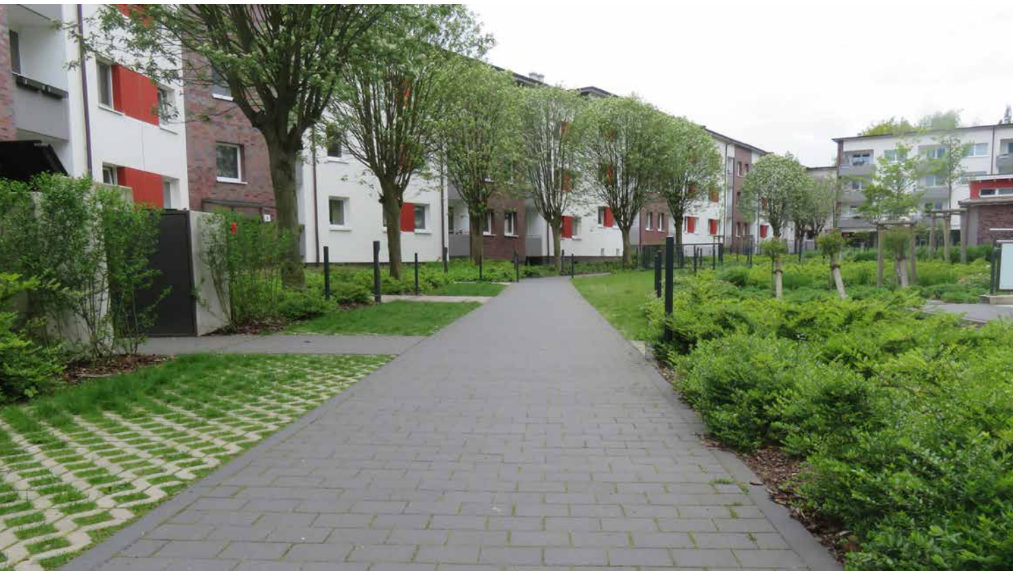
Abb. 69: Die Wohnungen der südlichen Bebauung werden über den innenliegenden Freiraum erschlossen (FINKE 2021)
