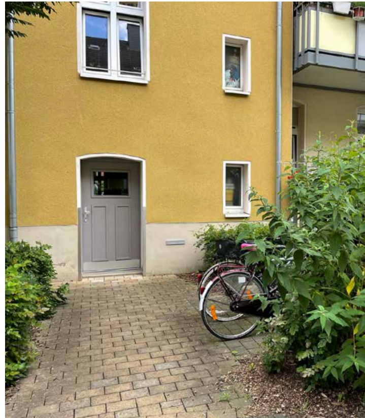
Abb. 42: Rückwärtiger Ausgang zum Innenhof (WINKING 2021)
