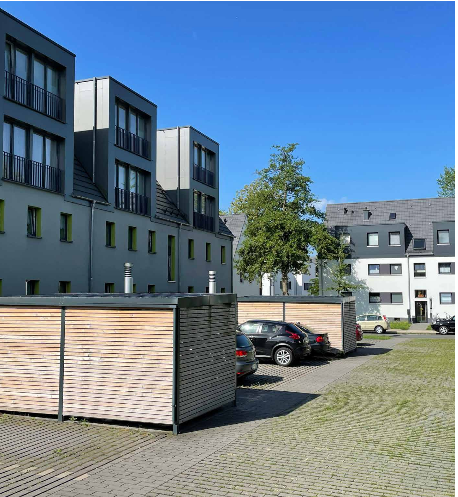
Abb. 130: Zufahrt und Stellplätze mit großfugigem Betonsteinpflaster. Weitere Formate unterstützen die fußläufigen Bereiche (WINKING 2021)
