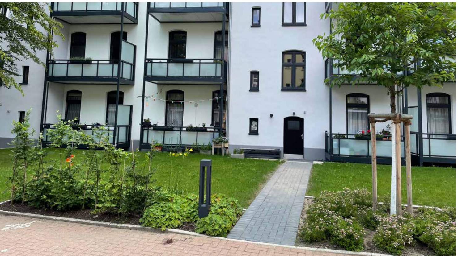
Abb. 115: Durchgang aus dem Treppenhaus in den Innenhof (WINKING 2021)
