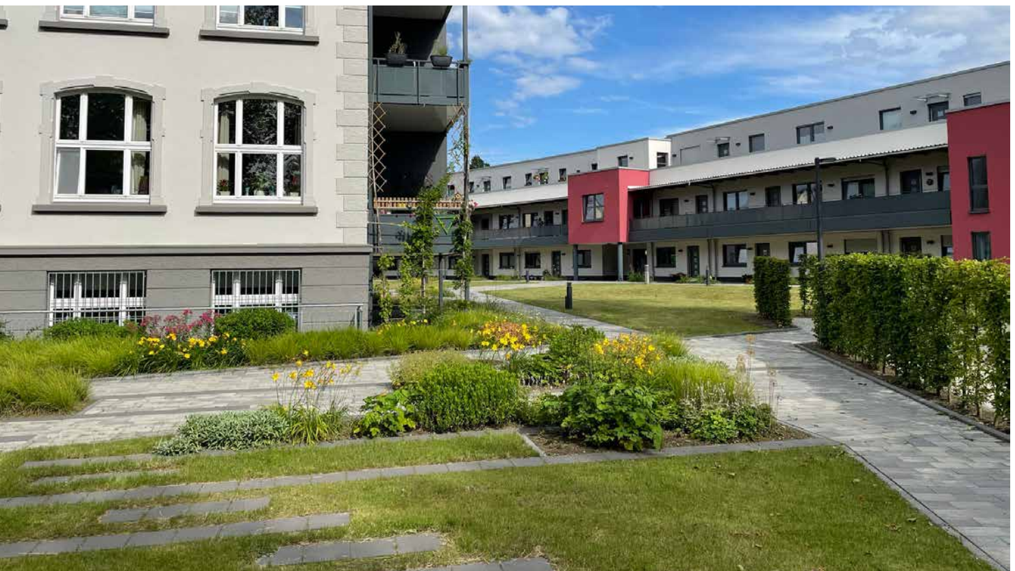
Abb. 30: Blick in Richtung Südosten zum Neubau des Quartiers (WINKING 2021)
