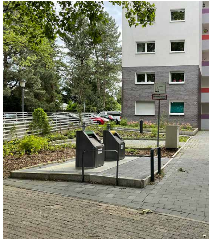
Abb. 57: Gut erreichbare Unterflurbehälter (WINKING 2021)
