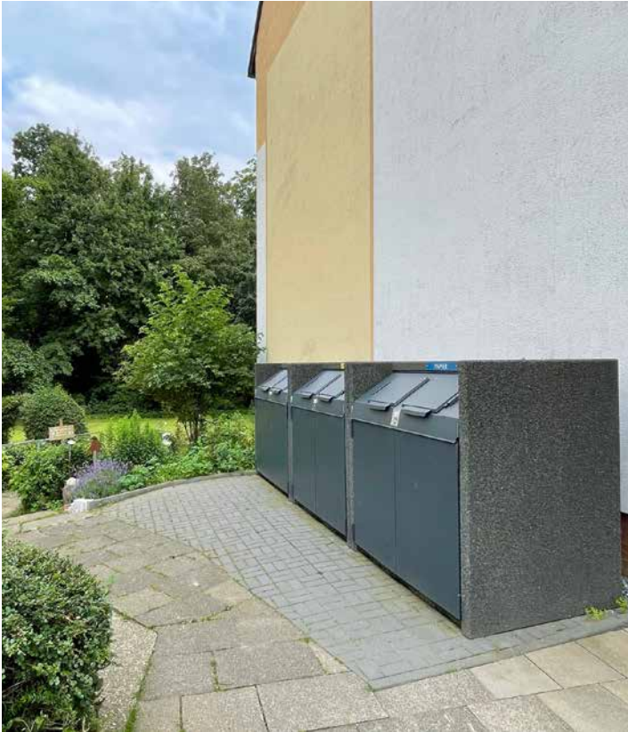
Abb. 108: Die Entsorgung muss aus Platzgründen direkt am Weg...
