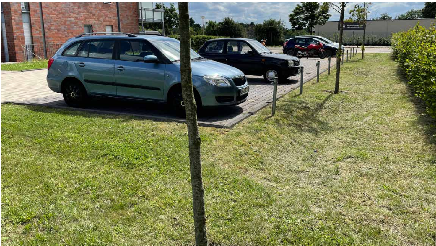
Abb. 91: Muldenversickerung in Kombination mit großfugigem Betonsteinpflaster (WINKING 2021)
