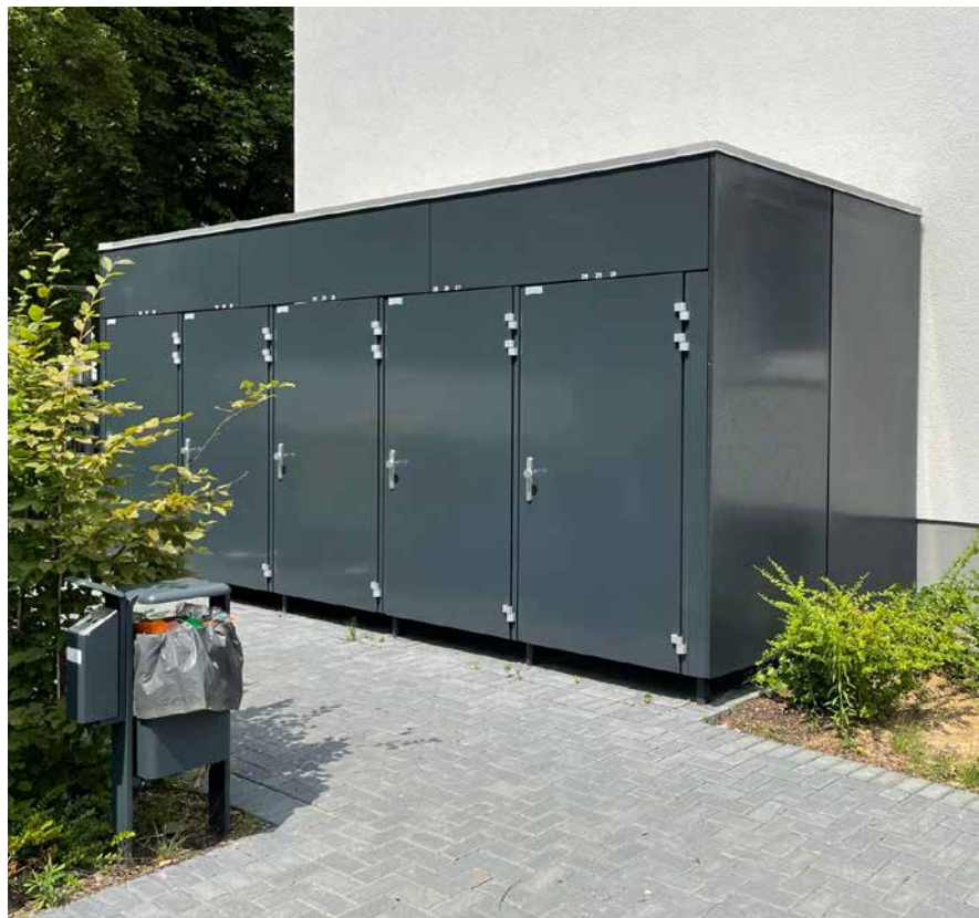
Abb. 79: Kellerersatzräume an der Stirnseite des Gebäudes (WINKING 2021)
