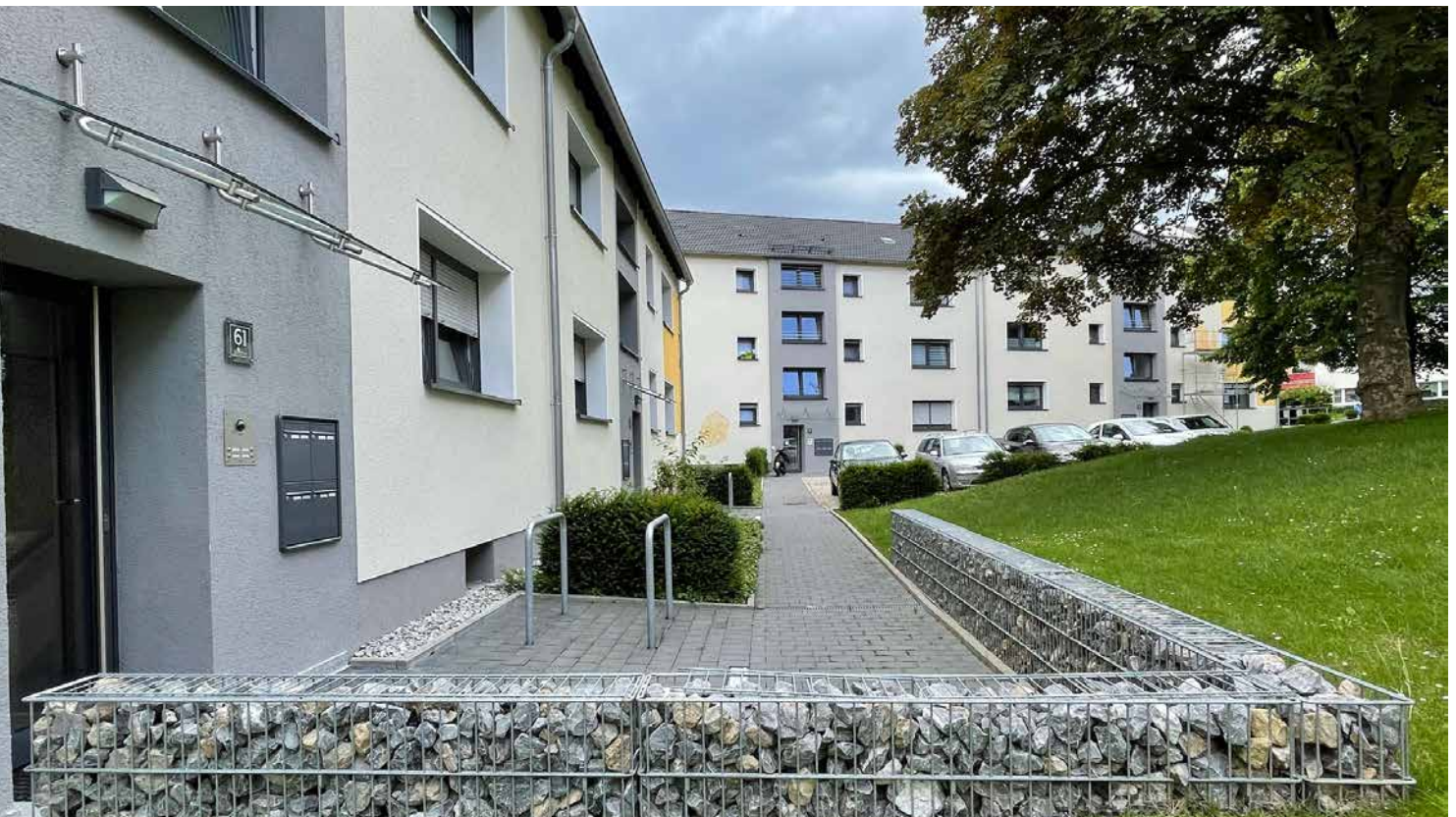
Abb. 61: Eingangsbereich mit Fahrradablenkbügeln nach der energetischen Sanierung (WINKING 2021)
