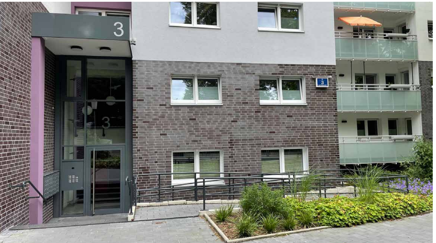
Abb. 51: Im Rahmen der Modernisierung neu gestalteter Eingangsbereich mit barrierefreier Erschließung (Winking 2021)
