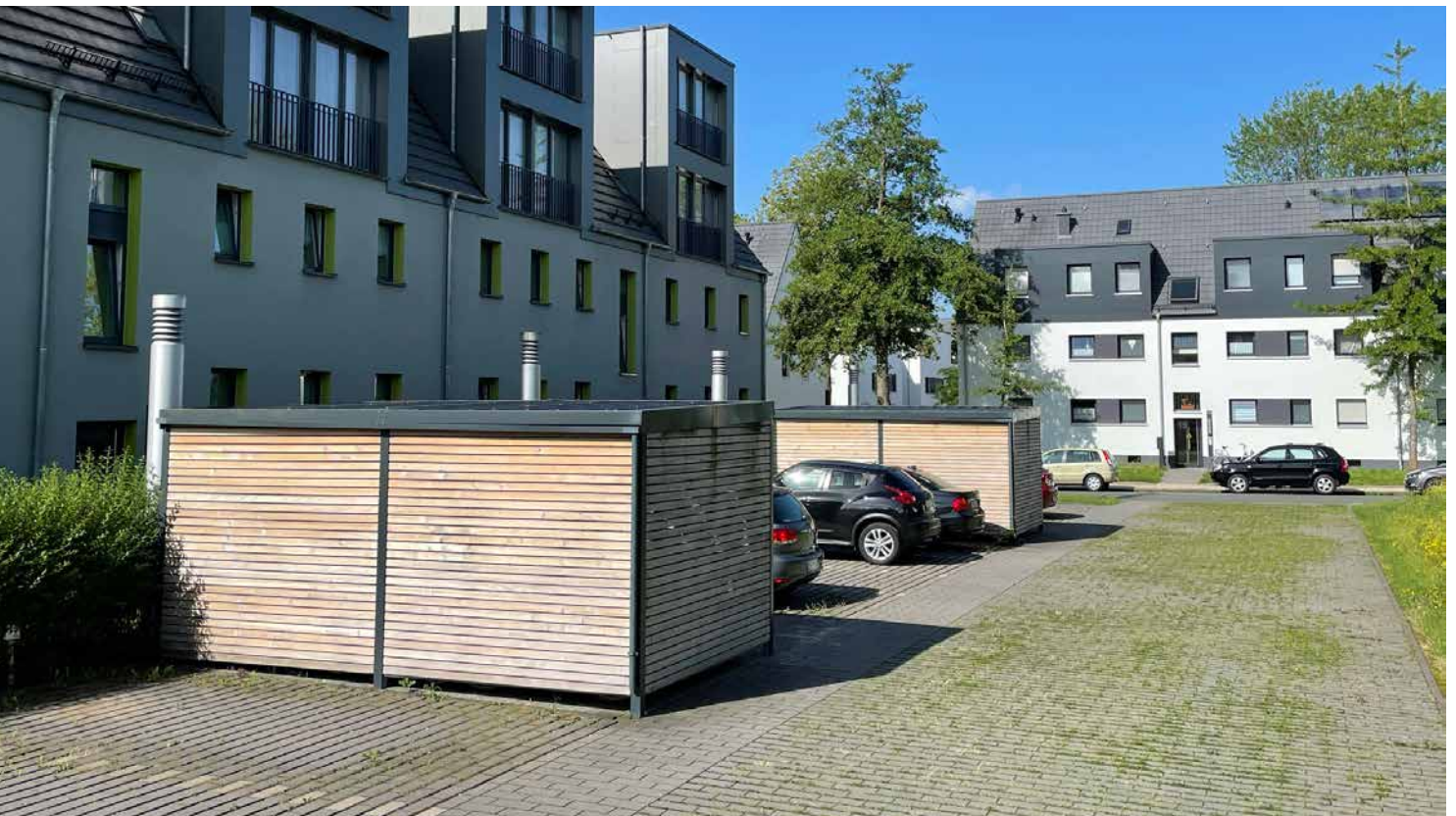
Abb. 22: Vorgelagerte Stellplätze mit versickerungsfähigem Betonsteinpflaster (WINKING 2021)
