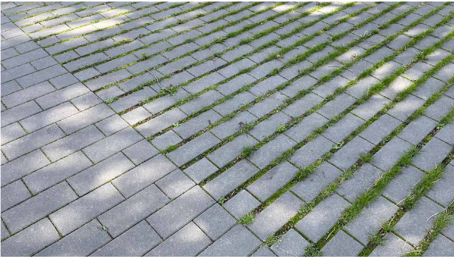
Abb. 08: Versickerungsfähige Bodenbeläge können nicht nur für Stellplätze verwendet werden (WINKING 2021)
