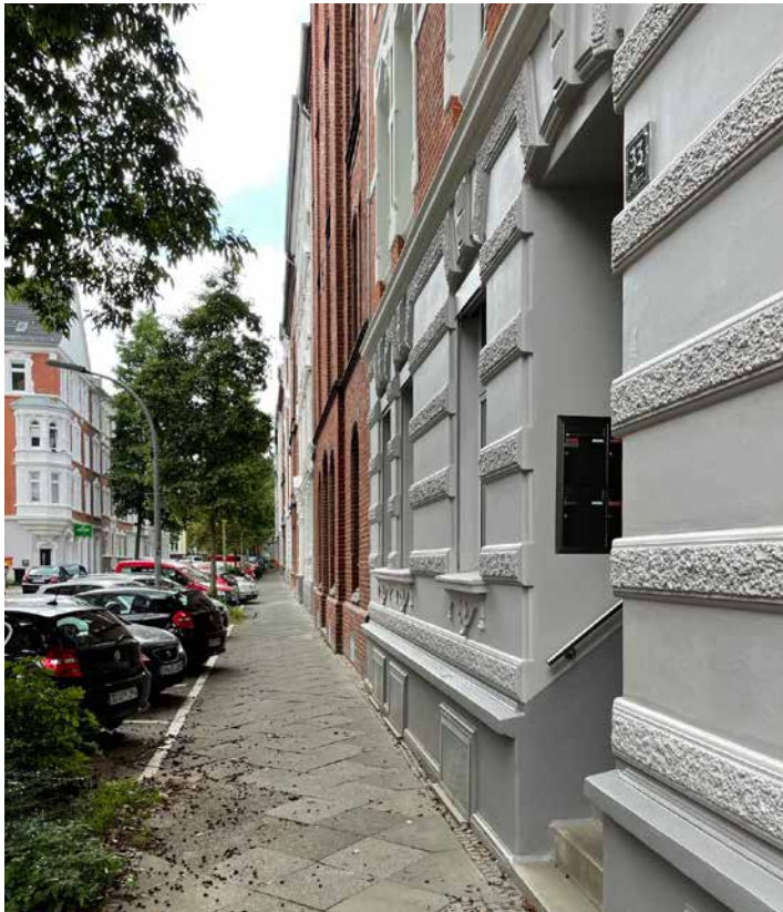
Abb. 41: Eingangsbereich von der Heinrichstraße (WINKING 2021)
