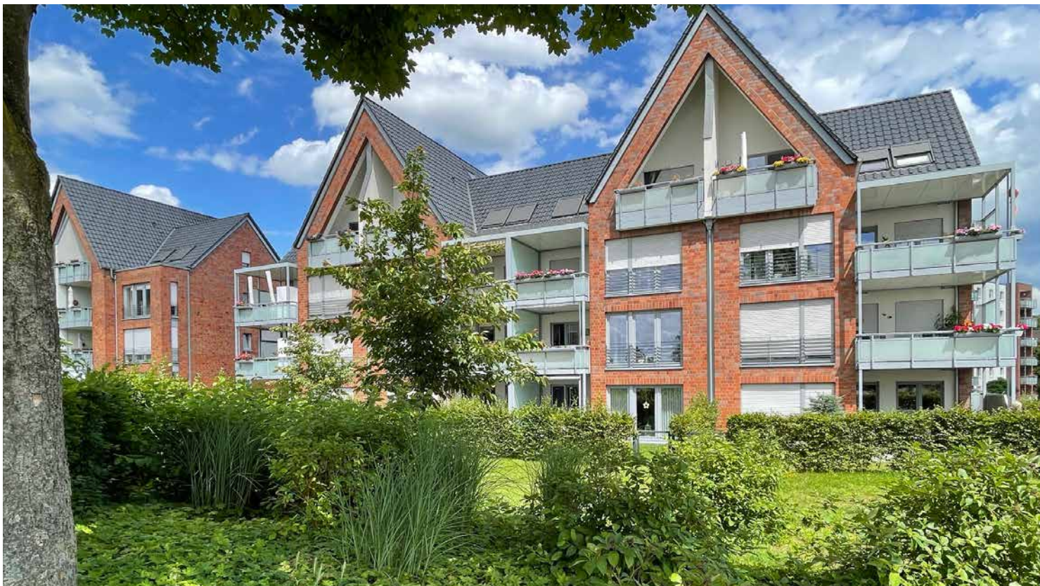
Abb. 05: Großflächig begrünte Freiräume an der Dachsstraße in Oberhausen (WINKING 2021)
