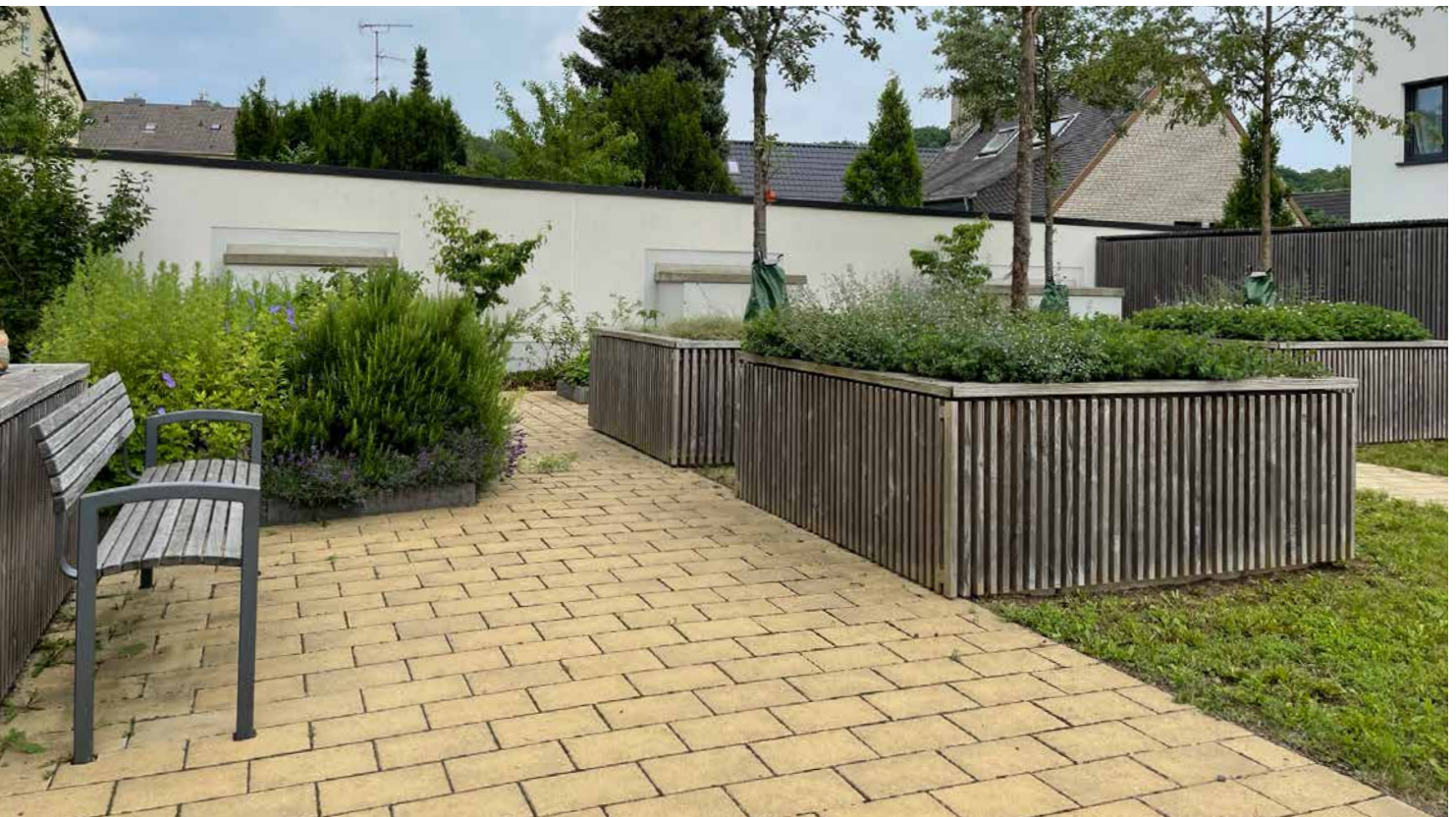
Abb. 122: Nur der Demenzgarten erhielt ein Betonsteinpflaster. Alle anderen Innenhöfe besitzen eine wassergebundene Decke (WINKING 2021)
